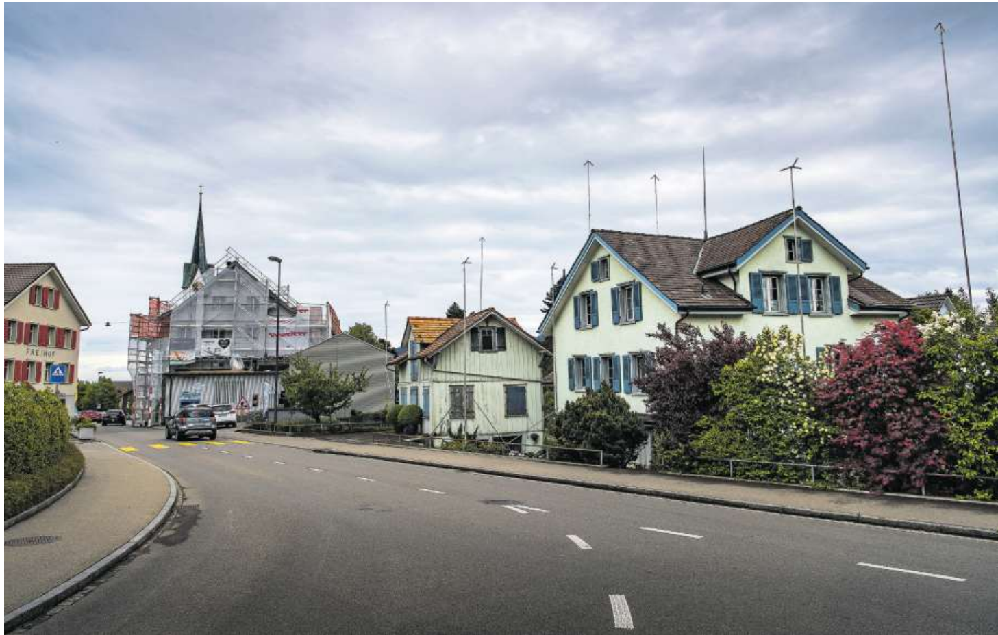
Die Visiere vorne im Bild verlangen noch Geduld. Weiter hinten wird bereits gebaut.
